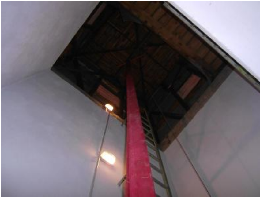
Der Schlauchturm... (Bild 2)
