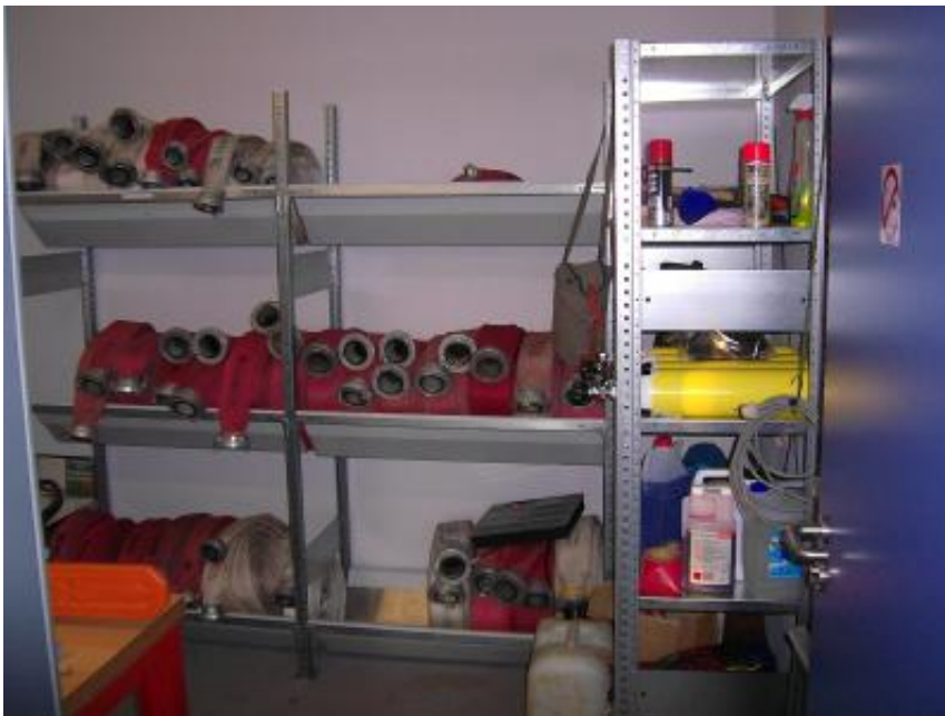
Der Schlauchturm... (Bild 1)
