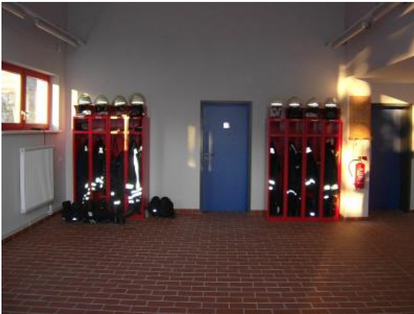
Die Fahrzeughalle... (Bild 2)
