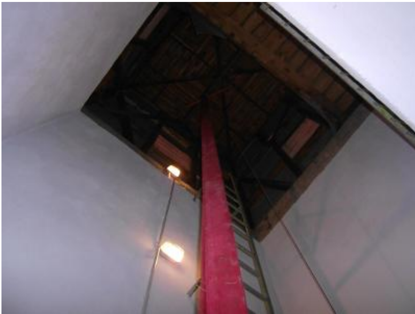
Der Schlauchturm... (Bild 2)
