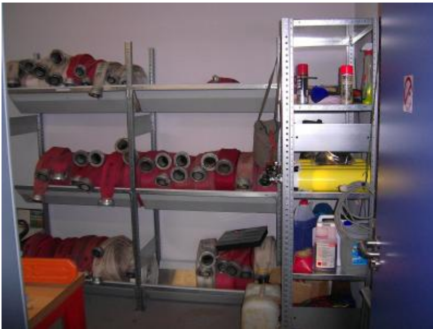
Der Schlauchturm... (Bild 1)
