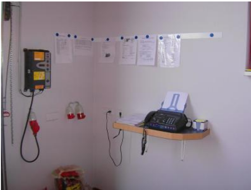
Die Fahrzeughalle... (Bild 1)
